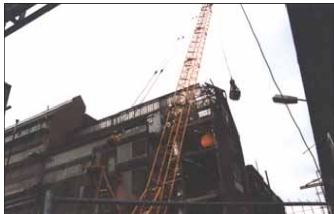
Der 2000 stillgelegte Essigsäure-/Anhydridbetrieb wird abgebrochen. Mit ihm verschwindet ein weiteres markantes Gebäude im Chemiepark.
