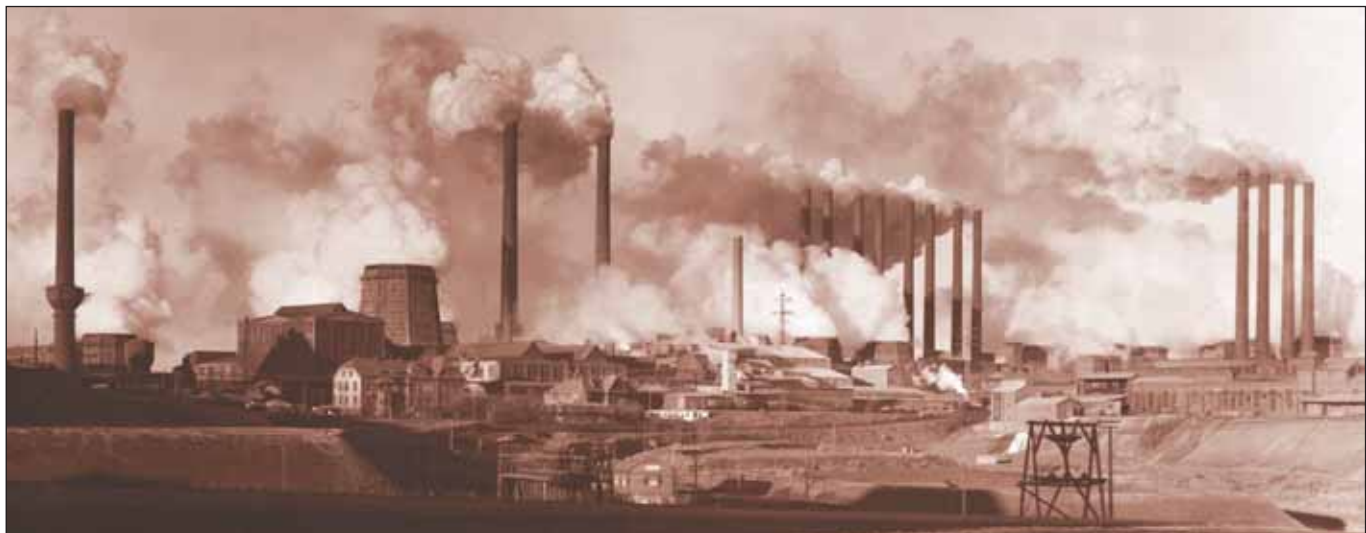
Der Aldehydbetrieb I am Pförtner 2 bei der Grubenstraße. Links der auffällige Generatorturm, der im Werk als „Pagode“ bezeichnet wurde. Nach Beschädigung im Zweiten Weltkrieg baute man ihn vereinfacht, mit geschlossenen, glatten Wänden wieder auf. Der Aldehydbetrieb I wurde am 29. Januar 1964 stillgelegt und 1967 abgebrochen.
