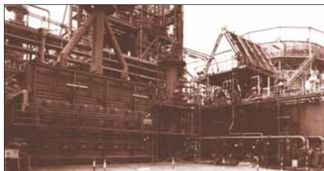
Der Betrieb Vinylchlorid II im Werksteil Knapsack; aufgenommen am 6. August 1964.
