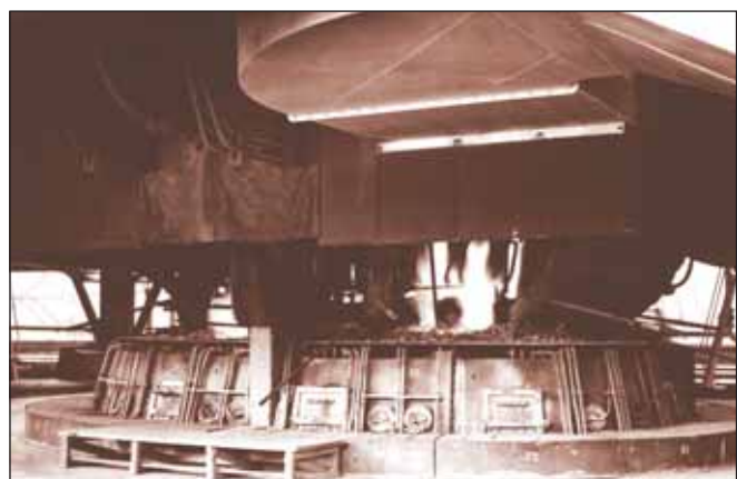
Der Carbidofen 8. Auf dieser Aufnahme ist gut die halb geschlossene Ofendecke zu erkennen. Diese Bauart war ein Fortschritt im Vergleich zu den bis dahin völlig offenen Carbidöfen.
