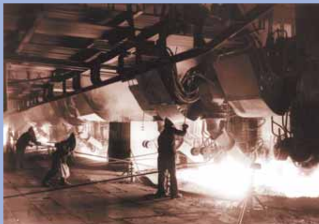
Im 1915 gebauten Carbidbetrieb waren mehrere offene Öfen vom System Helfenstein nebeneinander angeordnet, die ab 1921 auf Söderberg-Elektroden umgebaut wurden. In Schutzkleidung und teils in gehöriger Distanz verrichteten hier die Ofenmänner ihre Arbeit auf der Deckbühne.
