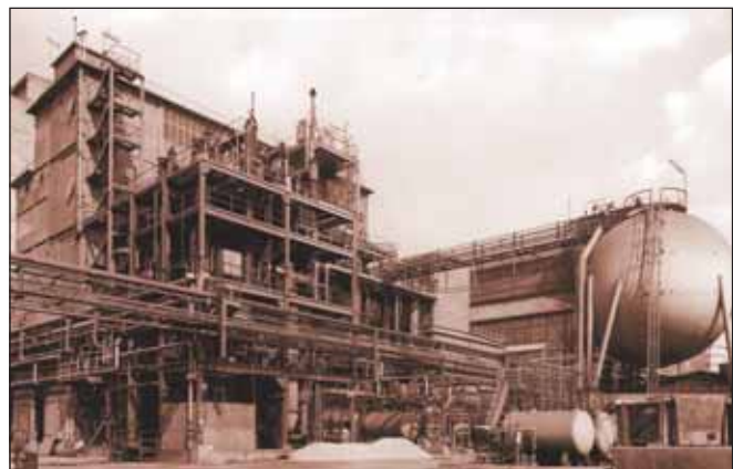
Die Vinylchlorid I-Anlage mitsamt Kugelbehälter in einer späteren, aber dafür anschaulichen Aufnahme vom 6. Juli 1964.
