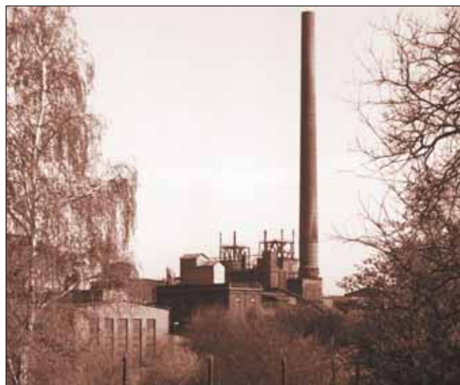
Der Kraftwerksschornstein nach dem Abbruch des Wasserbehälters. Links neben ihm die Gerüste am Carbidofenhaus und davor die Acetonfabrik. Alles, was auf diesem Foto vom 20. April 1993 zu sehen ist, existiert inzwischen nicht mehr. Foto: Helmut Neßeler
