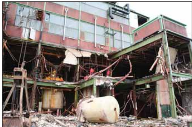
Keine Explosion, sondern ein geordneter Rückbau der Azo-Anlage war Gegenstand dieser Aufnahme.
