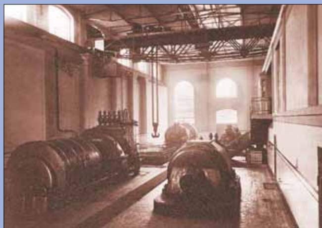
Das Maschinenhaus des 1908 erbauten Kraftwerks, des ersten in Knapsack überhaupt. Hier bereits im Zustand nach der baulichen Erweiterung von 1912/13. Die Giebelwand mit den Rundbogenfenstern stammt aus dieser Erweiterung; die Halle war in Richtung dieser Wand verlängert worden. Im Bild vier Turbogeneratoren. Vorne links einer der Firma AEG und rechts einer des Herstellers Brown, Boveri & Cie. Aufnahme aus der Zeit vor dem Zweiten Weltkrieg.
