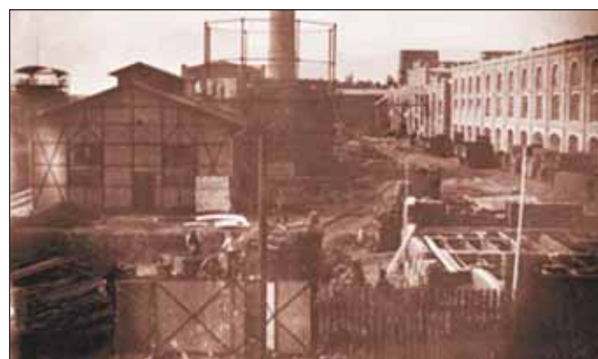
Das Werk der Gesellschaft für Stickstoffdünger in der Zeit seiner Fertigstellung. Vorne rechts wird gerade das Verwaltungsgebäude gebaut. Dahinter stehen bereits die Kalkstickstoff- und die Carbidfabrik sowie das Kraftwerk. Links ein Gebäude für Gasgeneratoren und ein Gasometer. Das Gas wurde bei der Herstellung von Stickstoff aus Kupferoxid benötigt.
