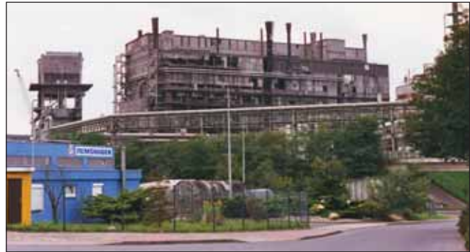
1996 begann der Abbruch des bis dahin so dominanten Phosphorofenhauses bei der Industriestraße. Am 11. September 1996 war es trotz fehlender Teile in der Fassade in seinem Umfang noch komplett.
