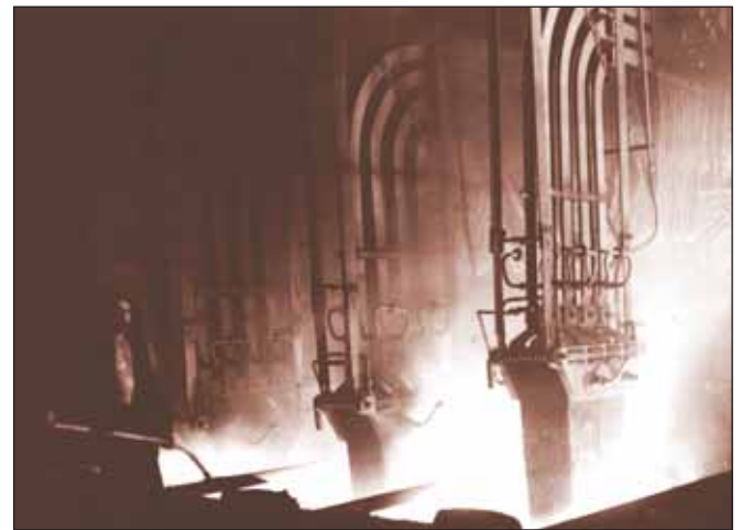
Ein Carbidofen vom System Helfenstein im Betrieb. Auffällig sind die drei nebeneinander angeordneten Paketelektroden, die in den Ofen hineinragen und ihn elektrisch heizen. Links ein Arbeiter, der den offenen Ofen mit der Schaufel von Hand mit Kalk und Koks befüllen musste, eine schwere Arbeit bei brutender Hitze.
