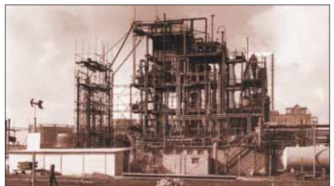
Die Aufnahme der Acrylnitril-Anlage im Aufbau. Sie stand im östlichen Werksteil beim Ort Knapsack.
