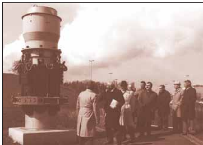
Nach der Aufstellung der Söderberg-Elektrode bei der Friedrich-Ebert-Straße in Hürth.
