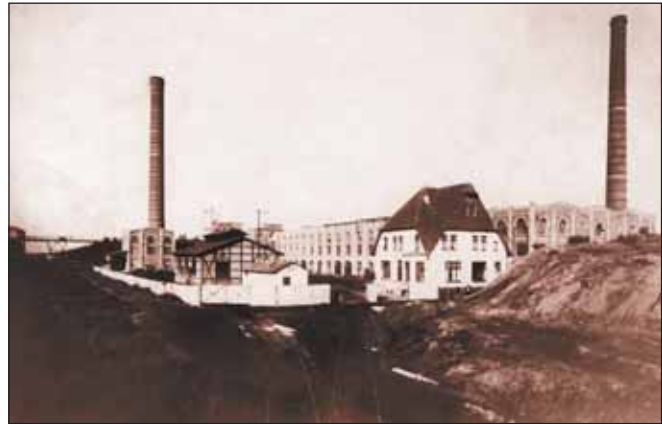
Das Werk der Gesellschaft für Stickstoffdünger in Knapsack in seinem Ursprungszustand von 1908. Aufgenommen von Süden, in etwa beim heutigen Wasserturm. Das Haus rechts neben dem Tor war das erste Verwaltungs- und Direktionsgebäude. Im langen Riegel hinter ihm befand sich die Kalkstickstoff-Fabrik. Im Fachwerkbau links hinter der Mauer standen Gasgeneratoren. Links dahinter die Mahlanlage für Kalk und Koks und der Schornstein des Kraftwerks.
