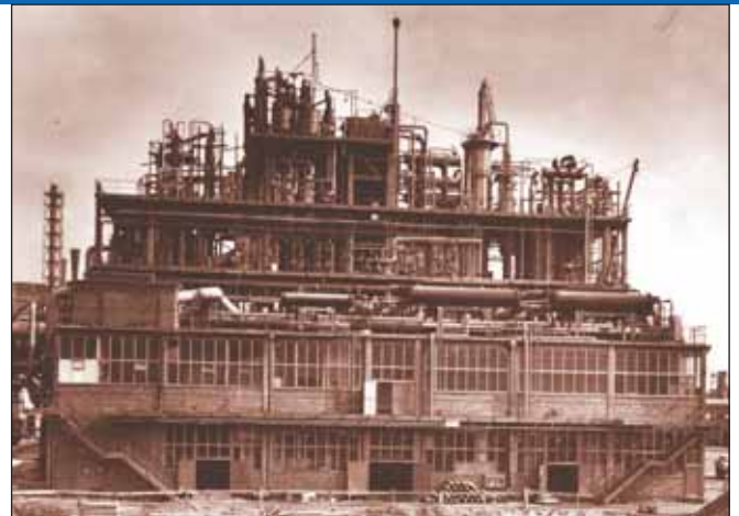
Die Mova/Chloropren-Anlage keine zwei Monate nach ihrer Inbetriebnahme; das Foto wurde am 16. April 1957 gemacht. Das Dickicht aus Röhren und Rohren steht nicht auf dem Dach, sondern dahinter. Die Anlage befand sich nahe dem Werksrand beim Wohnort Knapsack.
