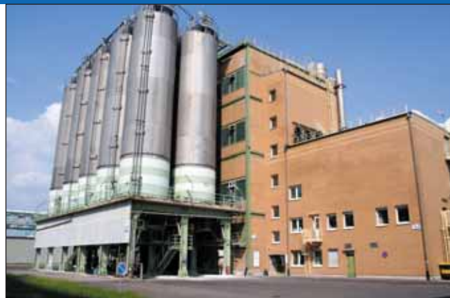
Die hoch aufragende Schichtsilikat-Anlage im Werksteil Hürth, die leider schwer ohne „stürzende Linien“ zu fotografieren war. SKS-6, ein Waschmittelrohstoff für Alltemperatur- und Standardwaschmittel, ging aus Knapsacker Forschung hervor und löste das Tripolyphosphat ab. Im September 2006 endete jedoch auch die Produktion von SKS-6.
