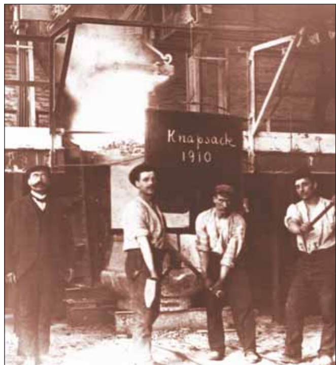
Diese Aufnahme von 1910 ist das älteste datierte Foto, auf dem Arbeiter des Chemiewerks zu sehen sind. Sie stehen vor einem der drei Lonza-Carbidöfen. Das Carbid wurde stündlich abgestochen, daher war die Mannschaft ununterbrochen beschäftigt. Links steht Elektromeister Heinrich Brock, der die technische Entwicklung der Carbidöfen maßgeblich beeinflusste. Brock war von 1906, von den Bauarbeiten an, bis 1932 im Werk.
