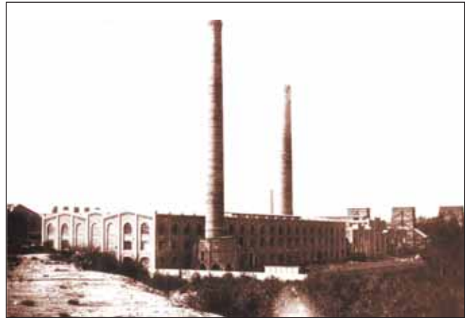
Ein bisher unveröffentlichtes Bilddokument von 1908: Die beiden ersten Fabriken des Chemiewerks, von einer Halde beim Ort Knapsack gesehen. Blick nach Osten. Der großzügig durchfensterte Riegel vorne ist die Kalkstickstoff-Fabrik mit Ofenhaus, Mahl- und Mischanlagen und Lager. Zum Ofenhaus gehört der 56 Meter hohe Schornstein links; der rechte zum Kraftwerk neben der Carbidfabrik, dies sind die Gebäude mit den abgestuften Giebeln, die in kurzem Abstand hinter der Kalkstickstoff-Fabrik stehen. Hinter ihnen drei Kühltürme des Kraftwerks. Am linken Bildrand Gebäude der Brikettfabrik „Vereinigte Ville“ der Bergwerksgesellschaft „Roddergrube“.
