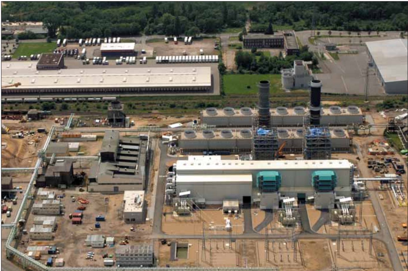
Kurz vor der Vollendung: Das Gas- und Dampfkraftwerk von Statkraft. Über 400 Millionen Euro wurden investiert, um jährlich 800 MW Strom zu erzeugen. Foto: Udo Beißel
