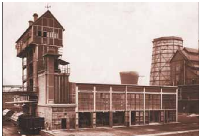
Die Bauten der Branntkalkanlage. Im Turm links befand sich ein Kalkschachtofen und in dem „Häuschen“ mit der Jahreszahl 1932 darüber versteckte sich ein Ventilator. Im niedrigen Gebäude rechts standen Pressen zum Brikettieren des Kalkhydrats. Im März 1934 wurde eine Erweiterung der Branntkalkanlage genehmigt, daher muss das Foto vor deren Ausführung entstanden sein.
