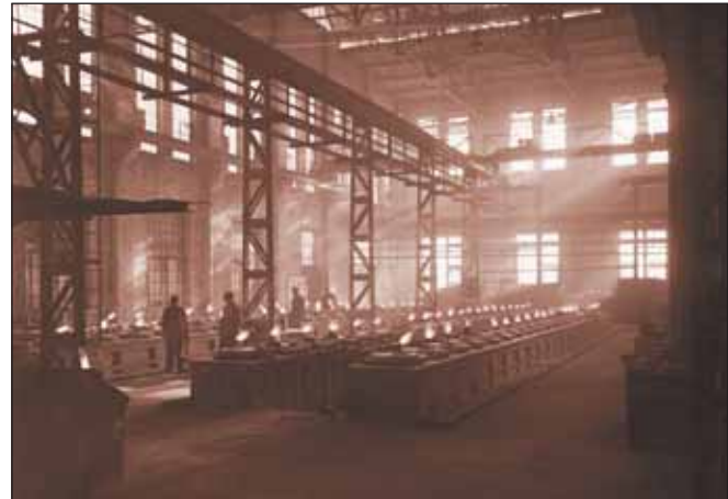
Blick in den Natriumbetrieb, in eine Halle mit Elektrolyse-Öfen. Zu sehen sind zwei gemauerte Doppelbänke, bei denen in jeder Reihe 21 gusseiserne Tiegel stehen, in denen mit Hilfe von elektrischem Strom aus geschmolzenem Ätznatron metallisches Natrium erzeugt wird. Dabei bildet sich Wasserstoff, der in den Flammen über den Tiegeln abbrennt.
