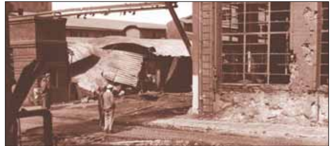
Nochmals der Bereich an der Hauptwerkstatt nach einem Angriff.
