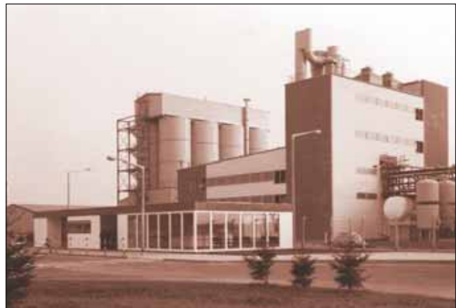
Mit der Polyvinylchlorid-Anlage begann in Knapsack die Produktion des wichtigen und vielseitigen Kunststoffes PVC. Die Anlage blieb nicht so bescheiden wie auf diesem Foto vom 2. November 1966, sondern wurde später erweitert.
