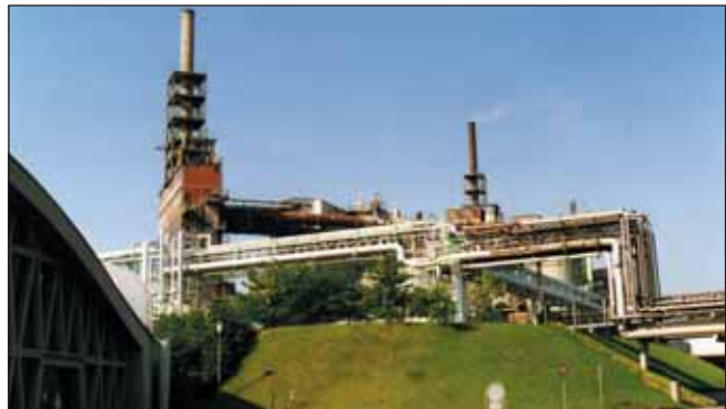
Am 23. Mai 1993 standen noch die weithin sichtbaren Schornsteine an der Werkszufahrt. Links jener der Phosphorsalz-Anlage, der 1967 auf den Tripolyphosphatsilo aufgesetzt worden war. Hinten rechts der Schornstein vom Phosphorsäurebetrieb. Quer durch das Bild verläuft die Rohrbrücke zum Werksteil Hürth.
