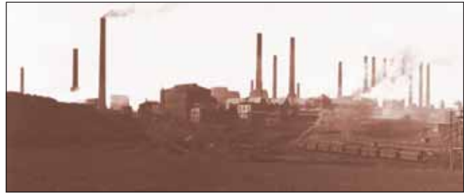
Die Aktiengesellschaft für Stickstoffdünger zusammen mit dem Goldenberg-Kraftwerk des Rheinisch-Westfälischen Elektrizitätswerk AG von Osten gesehen. Aufnahme aus der Zeit vor dem Zweiten Weltkrieg. In der rechten Bildhälfte ist ein Zug auf der „Schwarzen Bahn“ in der Kurve beim Haltepunkt Knapsack zu erkennen. Sieben Personenwagen hat die Dampflokomotive von Hermülheim über die steigungsreiche Strecke hinauf gebracht.
