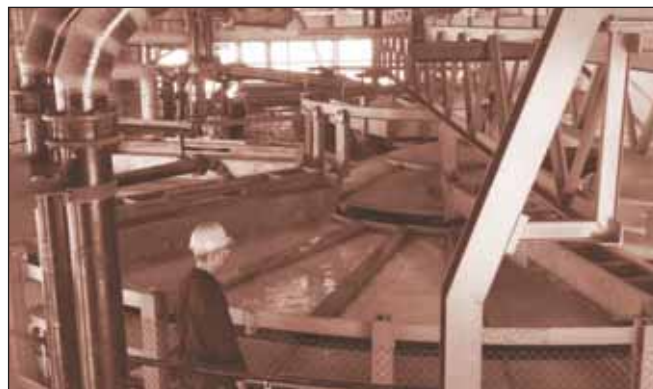
Blick in die Anlage zur Herstellung von Nassphosphorsäure im Werksteil Hürth, am 13. Juli 1966. Fast genau 25 Jahre danach, am 1. Juli 1991, endete hier die Produktion. Bis dahin wurden ungefähr 1,6 Millionen Tonnen Phosphorsäure hergestellt. Der Arbeiter auf dieser Aufnahme steht vor einem Drehfilter, in dem das Gemisch aus Rohphosphat und Schwefelsäure in Phosphorsäure und Gips getrennt wurde. Nassphosphorsäure wurde für Waschmittelposphate verwendet. Die Anlage wurde 1995 abgebrochen.
