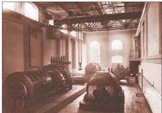
Die Maschinenhalle vom Kraftwerk, hier in einem bereits erweiterten Zustand mit vier Turbinenblöcken. Vorne links ein Turbogenerator des Herstellers AEG; der rechte daneben stammt von der Mannheimer Firma Brown, Boveri & Cie.
