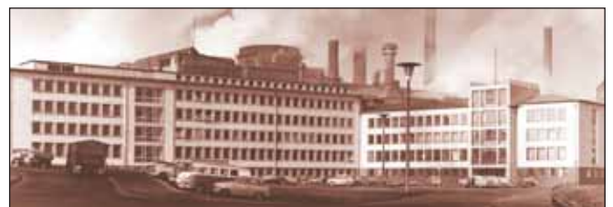
Das neue Verwaltungsgebäude nach seiner Fertigstellung; im Jahr 1957 aufgenommen. Im Hintergrund der dampfende Werkskomplex, wobei die höheren beiden Schornsteine zum Kraftwerk B II gehören. Die niedrigeren weiter vorne gehören zum Carbidofenhaus. Im Jahr 2007 wuchsen zwei ähnliche Schornsteine an ähnlicher Stelle hinter der Verwaltung empor, die diesmal zum neuen Gas- und Dampfkraftwerk gehören.
