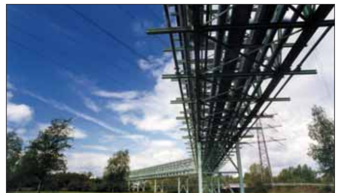
Die neue Rohrbrücke zwischen den beiden Werksteilen.
