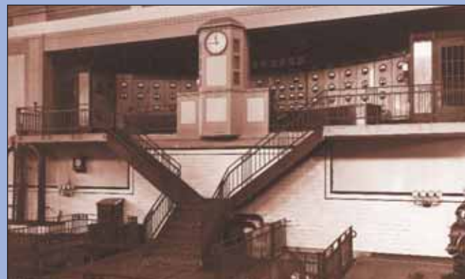
Die Schaltwarte im Maschinenhaus des 1908 erbauten Kraftwerks. Sie gehörte nicht zur Ursprungsausstattung, sondern war bei einer Vergrößerung des Maschinenhauses eingebaut worden, vermutlich bei der Kraftwerkserweiterung von 1912/13. Beeindruckend sind die im Halbkreis angeordneten Anzeigetafeln. Maschinenhaus wie auch Schaltwarte existieren nicht mehr. Da über einer der Tafeln das Wort „Natrium“ erkennbar ist und Natrium im Werk von 1922 bis 1929 hergestellt wurde, dürfte das Foto aus jenem Zeitraum stammen.
