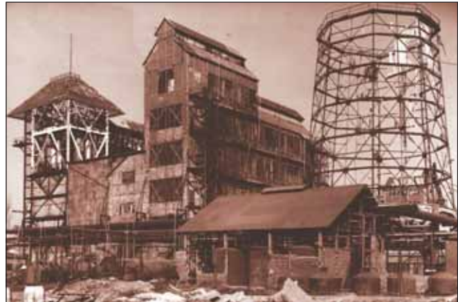
Der beim Luftangriff vom 28. Oktober 1944 sehr in Mitleidenschaft gezogene Aldehydbetrieb I beim Werkseingang am Pfortner 2 befindet sich hier am 25. Februar 1948 bereits im Wiederaufbau. Auch das noch als Rest verbliebene „Pagodendach“ auf dem Generatorturm verschwand bald darauf.
