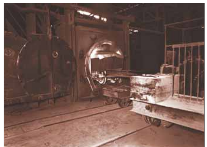
Ein geöffneter Kanalofen zur Kalkstickstoffherstellung. Hier die Beschickungsseite mit der Druckmaschine, von der die Kastenwagen mit dem Carbid in den 50 Meter langen Ofenkanal gedrückt wurden.
