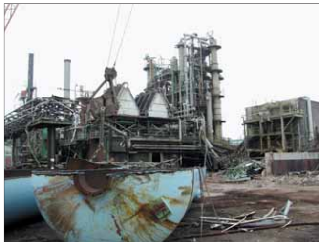
Aus Alt mach Neu: Der Abriss der alten VC-Anlage wurde durch den Bau der neuen VC-Anlage von Vinnolit notwendig. 800 Tonnen Stahlschrott fielen dabei an.
