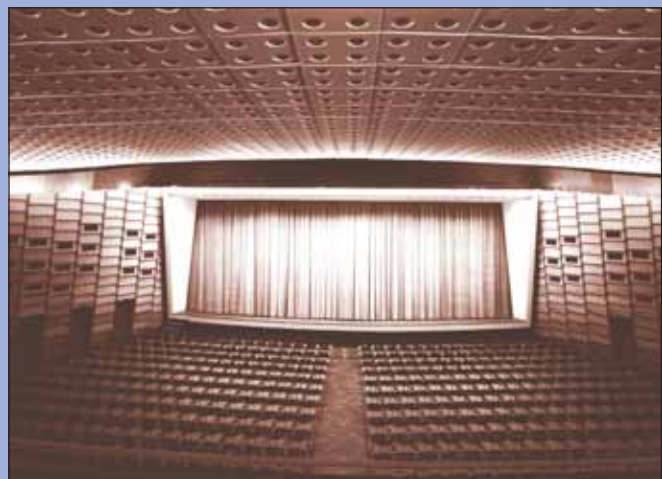
Der immer wieder eindrucksvolle Blick von der Empore durch den Saal zur Bühne; hier einmal ohne Gäste und ohne Veranstaltung. Umso deutlicher wirkt das Raumerlebnis. Die Decke aus vorgeformten Fertigteilen scheint über dem Saal zu schweben. Interessant ist auch die Gestaltung der Wandvertäfelung. Aufnahme vom 14. Oktober 1957.
