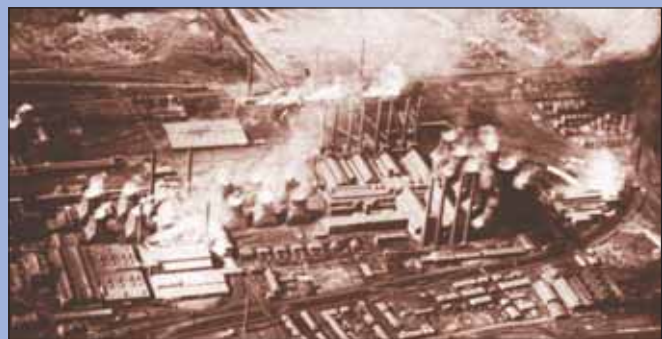
Luftbildaufnahme vom Goldenberg-Kraftwerk im Zustand nach seinem Endausbau, mit den charakteristischen zwölf Schornsteinen. Aufgenommen von Nordosten. Links neben den Schornsteinen sechs Kühltürme und neben diesen die Fuchskaulenstraße, die das Kraftwerk vom Chemiewerk abgrenzt. Gleich gegenüber steht das Kraftwerk B II, das sich durch seine beiden Schornsteine hervorhebt. Aufgenommen vor dem Zweiten Weltkrieg.
