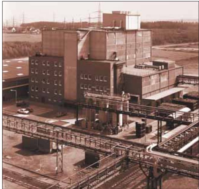
Die Azo-Pigmente-Anlage brachte Farbe in den Werksteil Hürth. Die Aufnahme stammt vom 11. Mai 1978. Im September 2005 stellte der inzwischen zur Firma Clariant gehörende Betrieb seine Produktion ein und im Dezember wurde das Gebäude zum Abbruch freigegeben.
