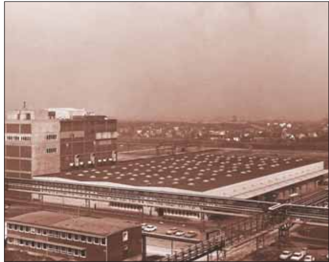
Die Polyethylen-Anlage mit weiträumiger Lagerhalle. Im Hintergrund die Häuser von Alt-Hürth. Aufnahme vom 25. April 1974.
