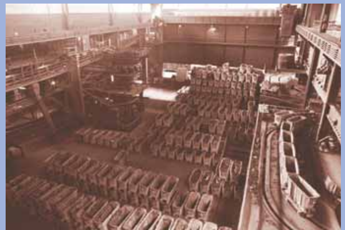
Aufnahme der Kühlhalle im Carbidbetrieb mit elischen Wagen der Tiegelbahn, in denen das aus den Öfen kommende Carbid abkühlte und erstarrte. Zwischen den Stapeln leerer Wagen stehen auf dem Boden auch einige gefüllte und in manchen glüht es noch.
