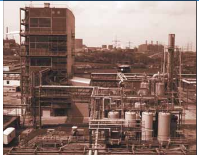
Der Pflanzenschutzmittelbetrieb im Werkteil Hürth in seiner ersten Ausbaustufe. Im Hintergrund links die Phosphorfabrik im Werkteil Knapsack und rechts das Goldenberg-Kraftwerk des RWE. Aufnahme von 1978.
