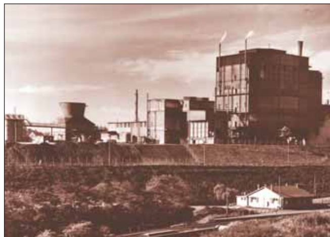
Die neue Phosphorfabrik um 1953. Rechts im Bild der auffällige Quader des Ofenhauses mit zwei Kohlenmonoxidgas-Fackeln. Später hatte jeder Ofen nur eine. Das Ofenhaus wurde bis 1963 zweimal nach links erweitert. Vorne die Strecke der „Schwarzen Bahn“ der Köln-Bonner Eisenbahnen und der Haltepunkt „Knapsack“.
