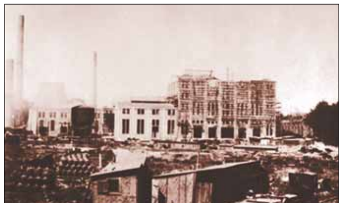
Eine Aufnahme von den Bauarbeiten zur Werkserweiterung 1915. Blick von Südosten zur Fabrik für Ammoniakwasser, die gerade aufgebaut wird. Hinter ihr entstehen die neuen, großzügigen Betriebe für Kalkstickstoff und Carbid. Der niedrigere, helle Bau hinter dem Behälter links wird die Lindeanlage (Lufttrennung) beherbergen.
