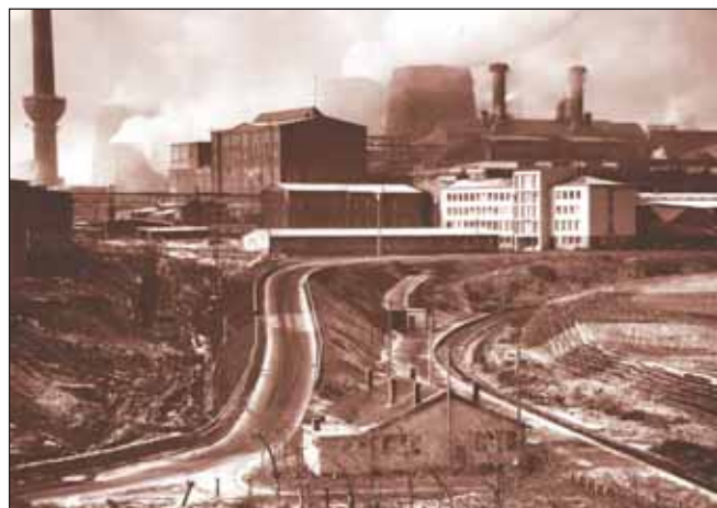
Blick vom Haltepunkt Knapsack an der „Schwarzen Bahn“ über die Auffahrt zum Werk, die geradewegs zum hellen, neuen Verwaltungsgebäude führt. Aufnahme von 1953. Links quer zum Neubau steht das, was von der früheren Verwaltung nach Kriegszerstörung und einfachem Wiederaufbau noch übrig ist. Dieses Relikt wurde im Sommer 1956 abgerissen. Im Hintergrund von links der Schornstein vom Kraftwerk B I, das Magazin, Kühltürme vom Kraftwerk B II und Carbidofen-Schornsteine.
