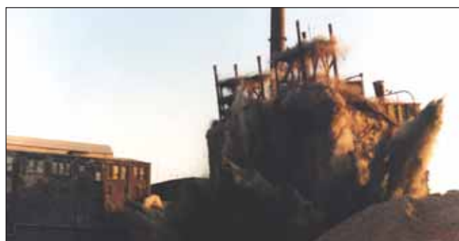
Sprengung der Carbidofen 10 und 20 am 18. Oktober 1994. Links das 2003/04 abgebrochene Magazingebäude. Hinter den fallenden Öfen ragt noch der Schornstein des früheren Kraftwerks B I auf, der jedoch ebenfalls 1994 weichen musste.
