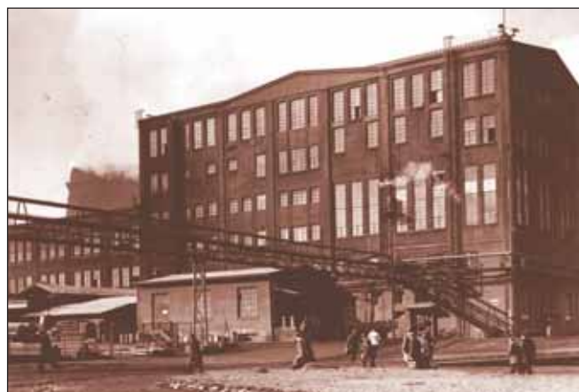
Die 1915 erbaute Ammoniakwasserfabrik. Der Stahlbetonbau war nach dem Krieg für viele Jahre das Magazingebäude des Chemiewerks und diente auch der Werksfeuerwehr als Unterkunft. Ab November 2003 wurde das Gebäude abgebrochen.
