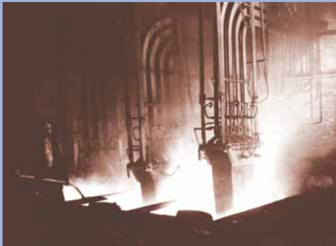
Die „zweite Stufe“ auf dem Weg zum leistungsfähigen Carbidofen war in Knapsack der hier im Betrieb abgelichtete Ofen vom System Helfenstein, der mit drei parallel in den Ofen hängenden Paketelektroden beheizt wurde. Links ein Arbeiter mit Schaufel.
