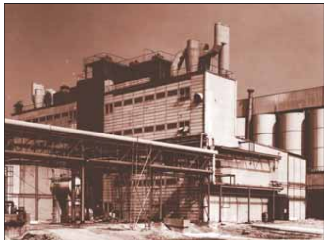
Die erweiterte Anlage zur Herstellung von Polyvinylchlorid (PVC) im Werksteil Hürth; um 1974 aufgenommen.
