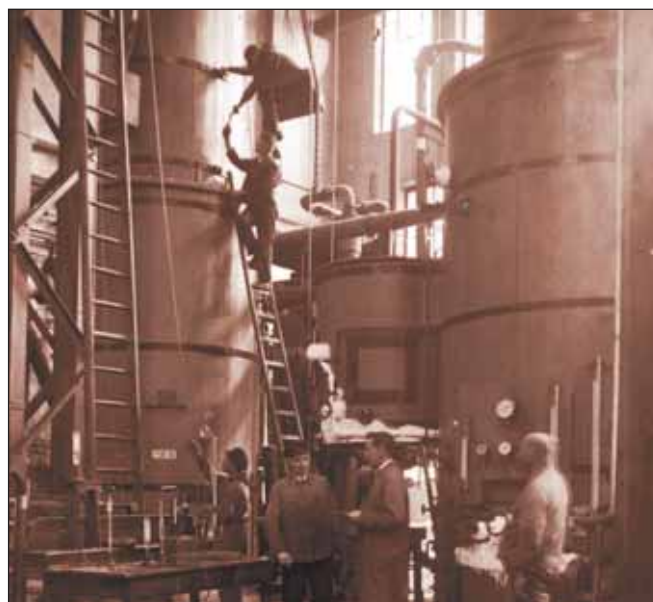
Eine Innenaufnahme in der Lindeanlage, um 1932 entstanden. Im Vordergrund stehen von links Meister Kierspel, Dr. Steinmetz und Herr Bäckmann. Die hohen Zylinder, an denen gearbeitet wird, sind die Apparaturen, in denen die Luft in Stickstoff und Sauerstoff getrennt wurde.
