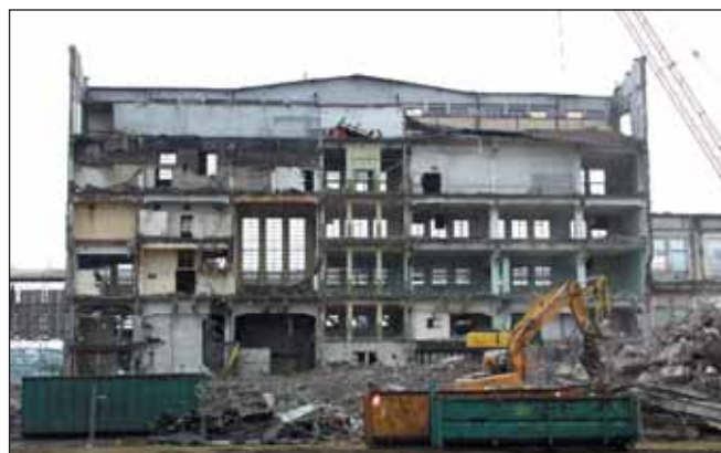
Der letzte Teil des früheren technischen Hauptlagers: Das Magazingebäude, ursprünglich die Ammoniakwasserfabrik für den Ersten Weltkrieg, im Abbruch.
