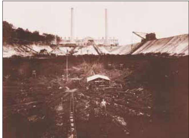
Der Anfang des Industriegebiets Knapsack: Aufschluss des Braunkohlentagebaus „Vereinigte Ville“ beim Bertrams Jagdweg mit den beiden Brikettfabriken Vereinigte Ville I und II im Hintergrund. Aufgenommen um 1903. Der Tagebau wurde einer der großflächigsten seiner Zeit und die beiden Brikettfabriken waren zusammen bereits eine der umfangreichsten Anlagen ihrer Art. Auf diesem Bild ist jedoch beinahe der Ursprungszustand zu sehen; links steht noch der Wald, der Knapsack damals umgab.
