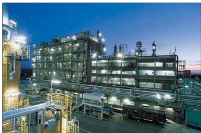
Eindrucksvolle Nachtaufnahme der Chloressigsäure-Anlage von CABB
