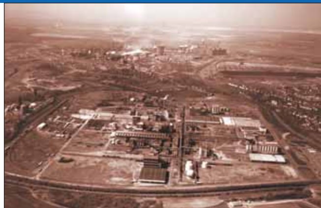
Luftaufnahme des gesamten Industriegebiets Knapsack und seiner Umgebung von Osten. Vorne der Werksteil Hürth der Hoechst AG. Die Aufnahme ist am 13. April 1980 entstanden.
