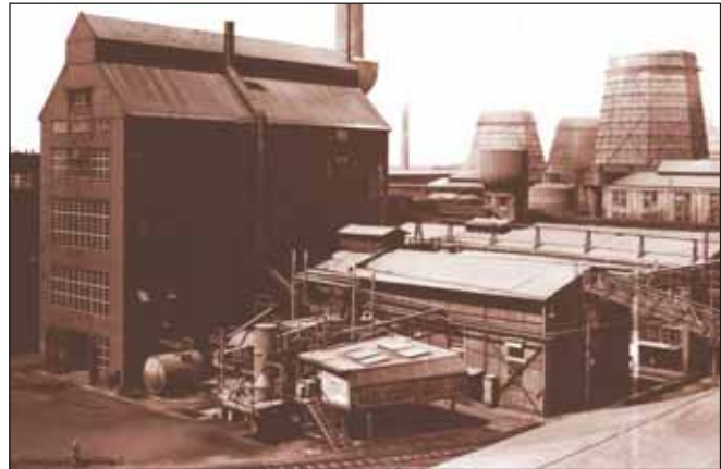
Der Essigsäure-Anhydridbetrieb, der sich nahe der Hauptwerkstatt und beim Magazin befand, von dem im Hintergrund rechts ein Stück zu sehen ist. Essigsäure-Anhydrid wurde in diesem Betrieb aus Kohlenmonoxid, Chlor und Essigsäure hergestellt. Später gelang die Herstellung durch Oxydation von Acetaldehyd.
